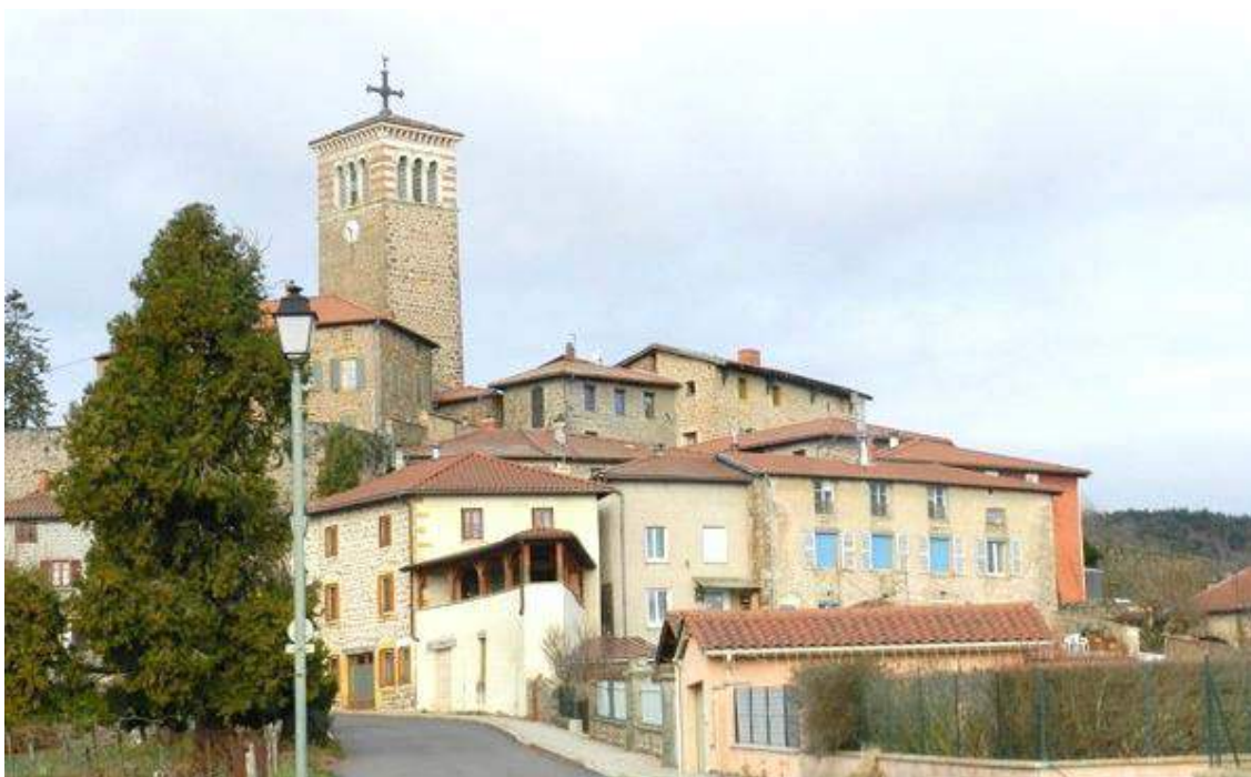
Vue sur le Bourg depuis la Route de Lyon (Sud Bourg) (1)
